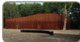
Booster station Hoogvliet
