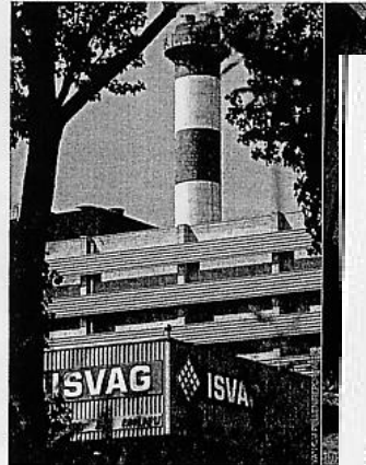
WILRIJK, ISVAG-OVEN. Een schoorsteen tussen mens en milieu.
