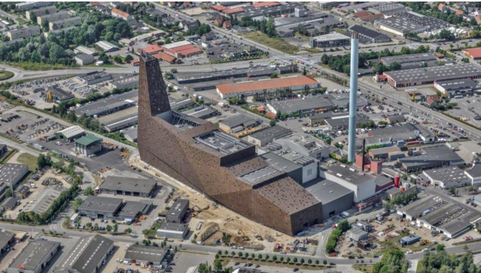
Thermische Abfallbehandlungsanlage in Roskilde, Dänemark, mit freundlicher Genehmigung von MARTIN GmbH für Umwelt- und Energietechnik
