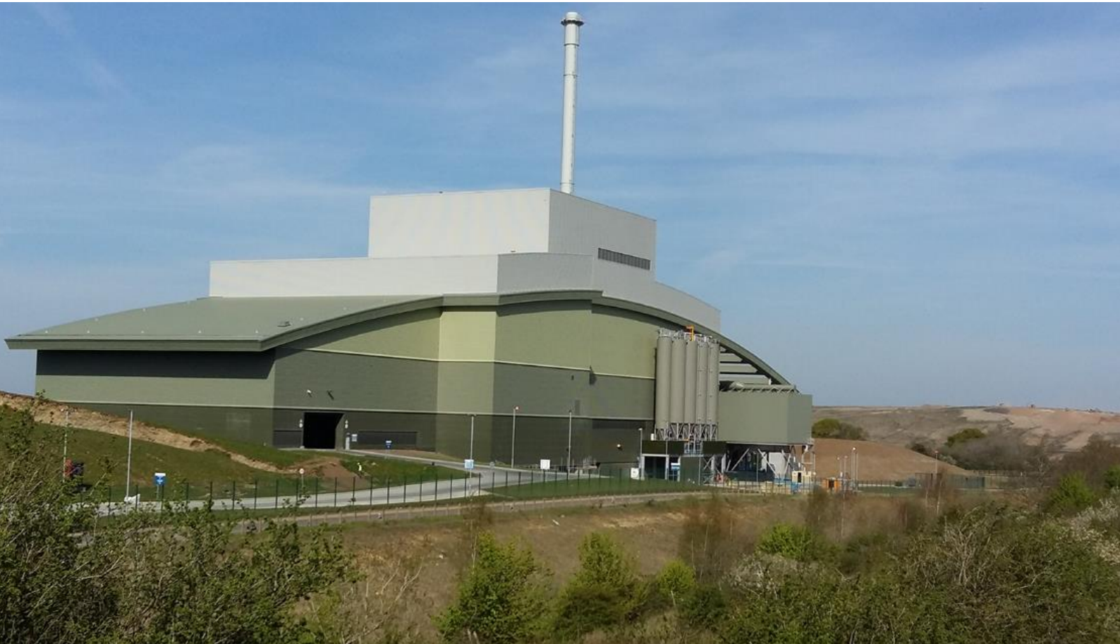
Thermische Abfallbehandlungsanlage in Greatmoor, Buckinghamshire, Vereinigtes Königreich, mit freundlicher Genehmigung von Hitachi Zosen Inova
